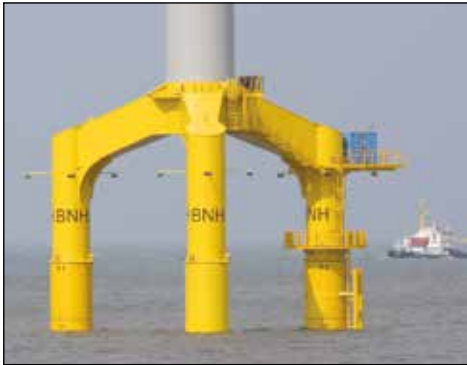
▲ Waterpas zetten van offshorewindturbines: het synchrone hefsysteem van Enerpac bood de oplossing voor het vlakstellen van de ondersteunende kruisstukken voor 80 windturbines.
