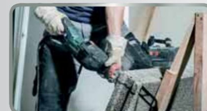
Reciprozagen kunnen dankzij het universele zaagbladassortiment worden gebruikt in de meest verschillende materialen, zoals hier in gasbeton.
